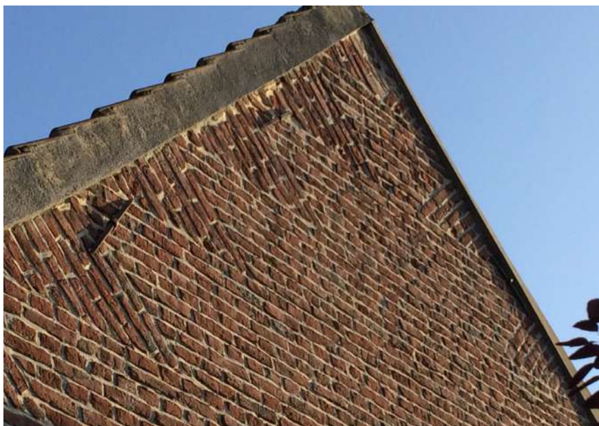
Fig. 105 : Disposition en épis des briques à la pointe du pignon, 2019 (Source : Parc naturel)
