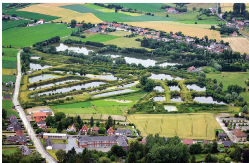
Fig. 259 : Les bassins vus du ciel (Source : ©EDA)
