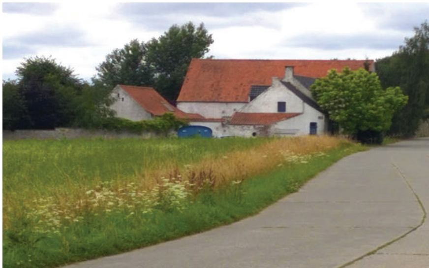
Fig. 104 : Ferme picarde, 2019 (Source : Parc naturel)
