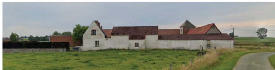
Fig. 128 : Ferme en carré, rue de Maubray (Source : Google, 2021)
