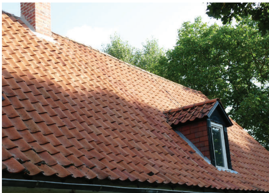
Fig. 97 : Toiture en tuile rouge, 2019 (Source: Parc naturel)
